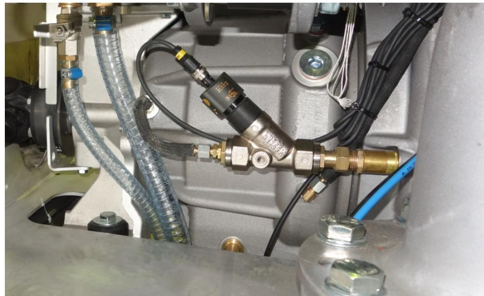
Для предотвращения работы насоса всухую на экране информационного дисплея имеется контроль потока воды, направляемого на охлаждение подшипников скольжения стального вала пожарного насоса.
